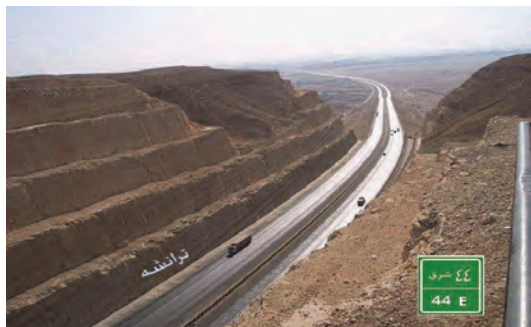
شکل ۹- ترانشه (شیروانی‌های خاکی اطراف راه)
