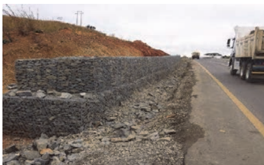
شکل ۱۰- دیوارهای گابیونی کنار راه
