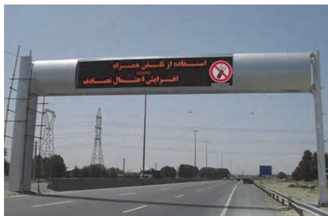
شکل ۱۶- نمایی از تابلوهای پیام متغیر
