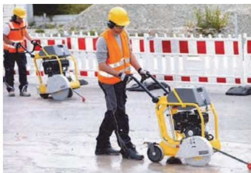
شکل ۱۷- دستگاه برش آسفالت دستی
